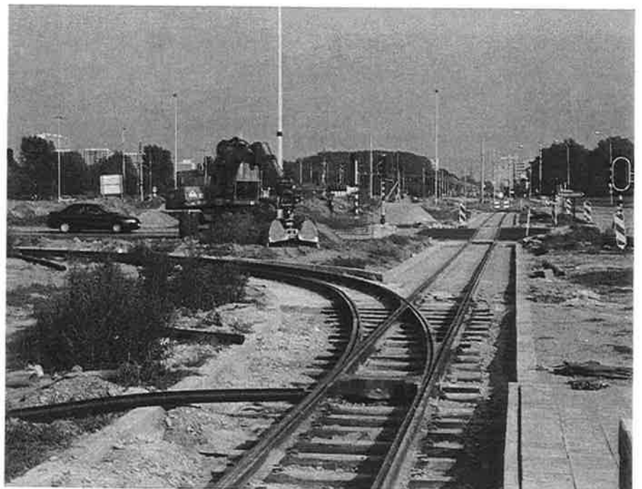
Nog een foto, hier aan het begin van de keerlus van de in aanleg zijnde eigen tram- en busbedding tussen het huidige eindpunt en de verlenging naar de kern van Zwijndrecht. Foto : Alain Janmart.
